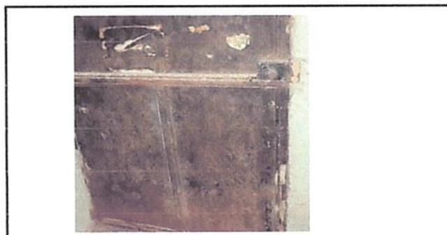
Foto 4: sustitución de chapa de puerta y mantenimiento (lijado, sepillado y aplicación de pintura)
