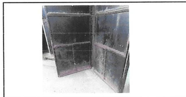
Foto 6: Mantenimiento de puertas de metal (lijada, sepillado y aplicación de pintura)
