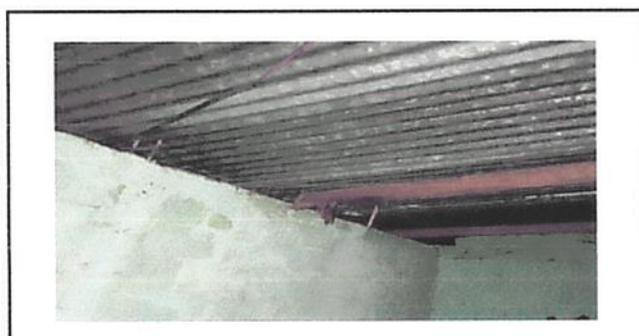
Foto 3: sustitución de soporte de madera por metal
