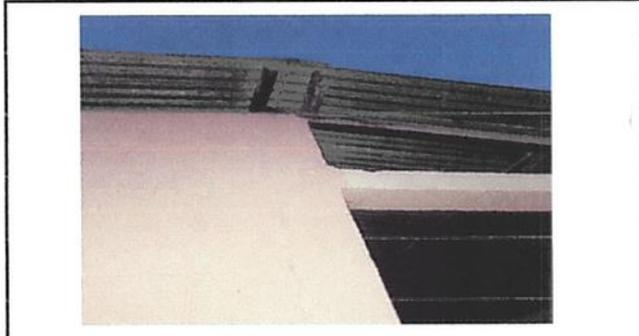
Foto 2: sustitución de capote de lamina troquelada
