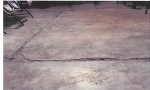
Foto 6: sustitución de piso de torta de concreto alisado
